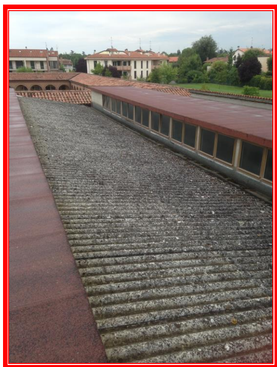
Foto 5 – Copertura da sostituire
